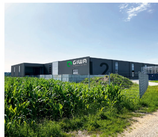
GIWA Unternehmensgebäude in Westendorf nördlich von Augsburg
