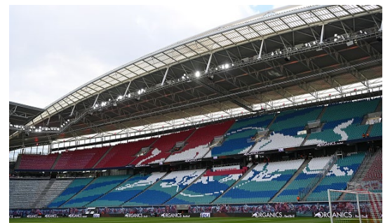
Die Installation der neuen Sitzschale erfolgte durch einen Experten für Stadion Bestuhlung während des laufenden Bundesliga Spielbetriebes.
